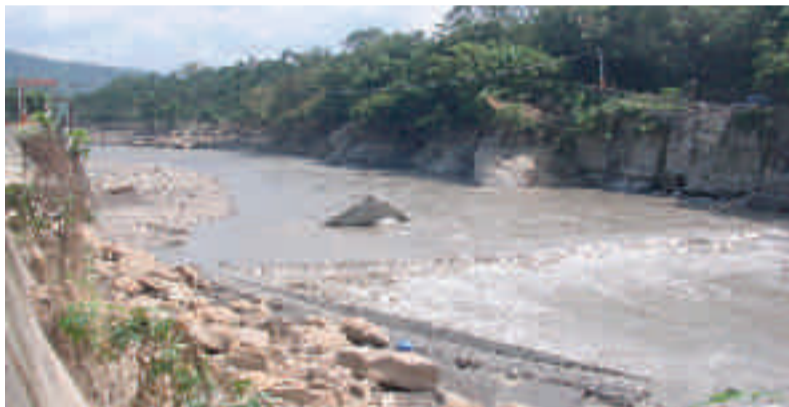
辛樂克強颶大水沖走昌榮橋原址橋不見了
