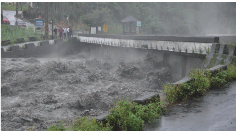
港門橋水位高漲橋面
